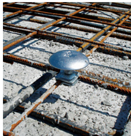
La foto mostra un captatore a fungo SP400500 ancorato alla rete elettrosaldata della pavimentazione di un parcheggio scoperto posto sulla copertura di un edificio.
