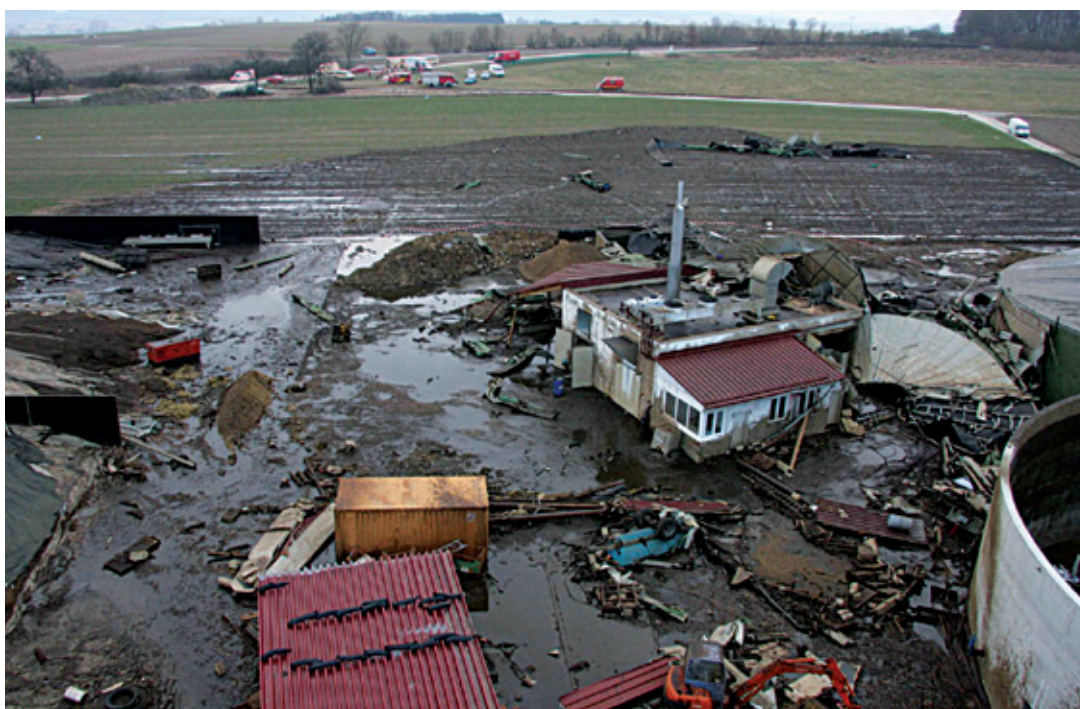
Esplosione di un impianto per la produzione del biogas (digestore anaerobico) a Daugendorf (Germania) (Fonte: www.feuerwehr-riedlingen.de )
