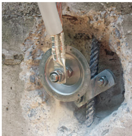
La foto mostra un esempio di connessione ai ferri d'armatura di una struttura in cemento armato già esistente, mediante il dispositivo SP560616 e relativo morsetto SP555301.
