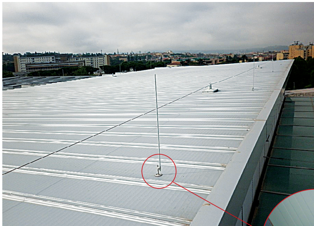
◀ Ospedale Careggi (FI), nuovo reparto maternità. La foto mostra un sistema di protezione ad aste di captazione.
