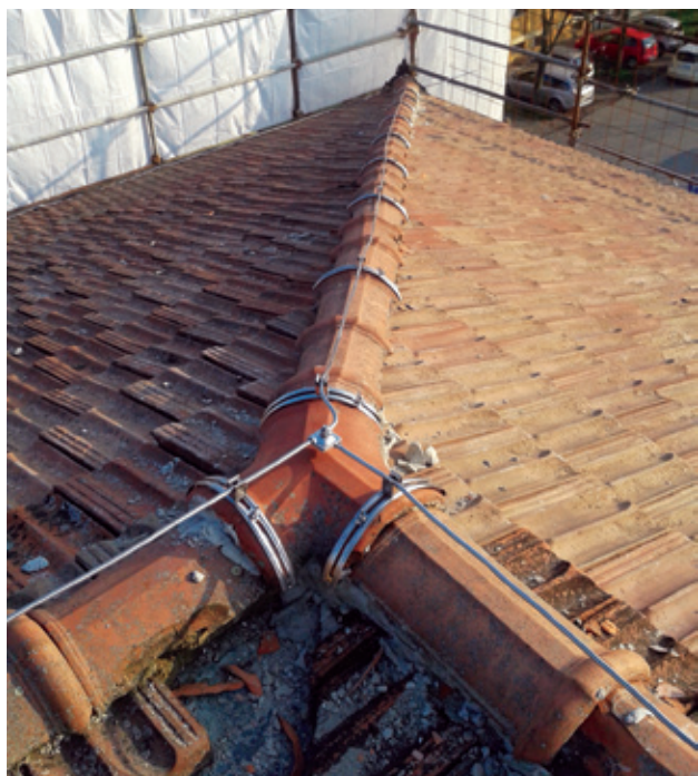
◀ Scuola primaria "Quaquarelli" San Giovanni in Persiceto (BO) - La foto a fianco mostra un sistema di protezione a maglie appoggiato realizzato su un coperto non combustibile e non conduttivo a protezione di una struttura debole.
