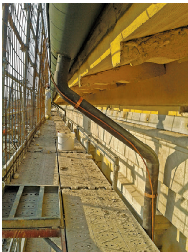
▲ Scuola primaria "Quaquarelli" San Giovanni in Persiceto (BO) - la foto sopra evidenzia il particolare della calata. L'impatto estetico è ridotto fissando la calata al pluviale.
