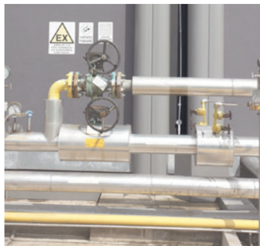
▲ La foto evidenzia una calata che non ha i requisiti per essere posizionata all'interno di una zona Atex.
