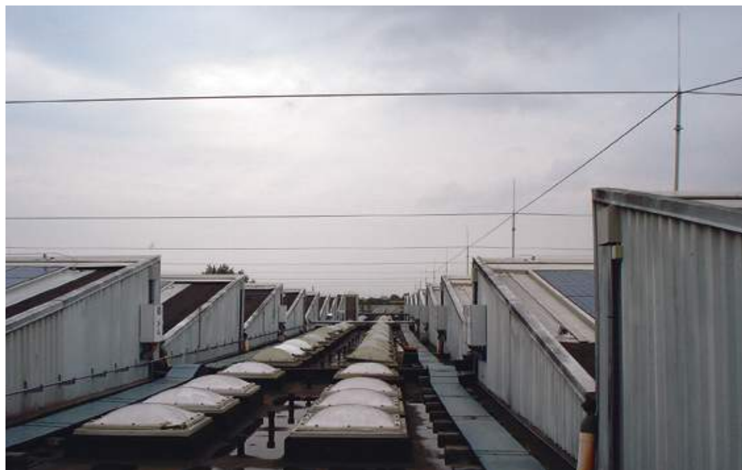
◀ Impianto di protezione a funi sospese su pali di supporto a protezione di struttura in cemento armato prefabbricato con impianto fotovoltaico in copertura.
