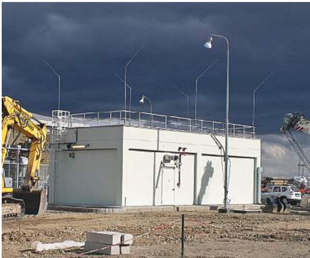
▲ La foto mostra un impianto di protezione in ambiente petrolchimico con aree Atex esposte, realizzato con aste di captazione su pali PPI con calata integrata. La struttura in c.a.v. è utilizzata come elemento naturale di calata.
