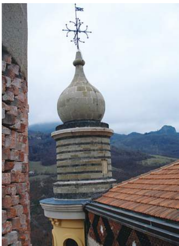
◀ Rocchetta Mattei - Grizzana Morandi (BO) - la foto a fianco mostra un sistema appoggiato a protezione di una struttura debole (realizzata in muratura) con copertura non combustibile. Particolare della protezione della torre.
