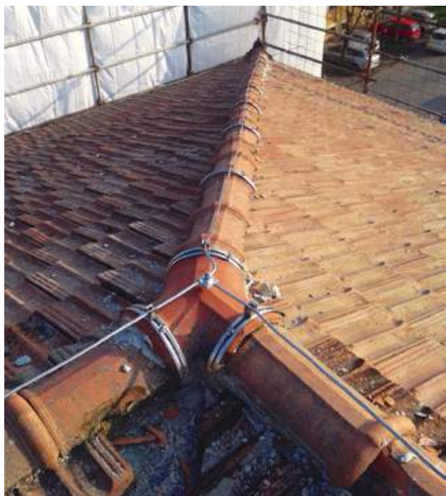
◀ Scuola primaria "Quaquarelli" San Giovanni in Persiceto (BO) - La foto a fianco mostra un sistema di protezione a maglie appoggiate realizzato su un coperto non combustibile e non conduttivo a protezione di una struttura debole.
