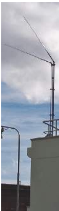
▲ La foto mostra il particolare di due aste inclinate montate su palo di sostegno rinforzato, con calata integrata.
