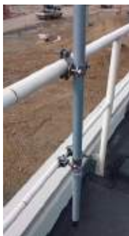
▲ La foto mostra il particolare dell'ancoraggio a parapetto di un palo di sostegno con calata integrata.
