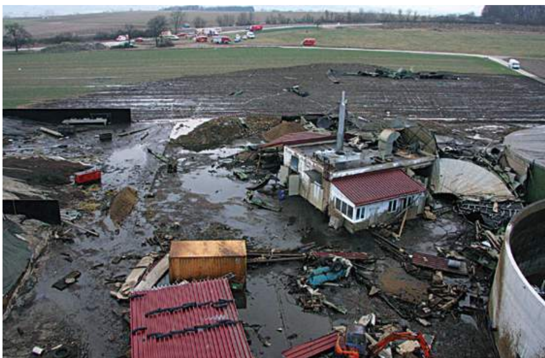
Explosione di un impianto per la produzione del biogas (digestore anaerobico) a Daugendorf (Germania) (Fonte: www.feuerwehr-riedlingen.de )
